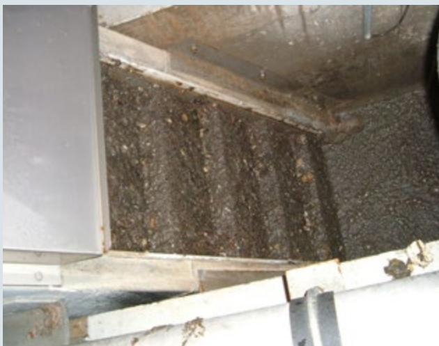
Рис. 6. Насосная станция для приема стоков и решетка до и после применения GREASOLUX.
